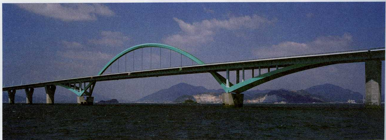
海上から見る。全長2.1kmのうち主径間部の400mが鋼モノコード式バランスドアーチ橋となっている(写真:岡本公二)
